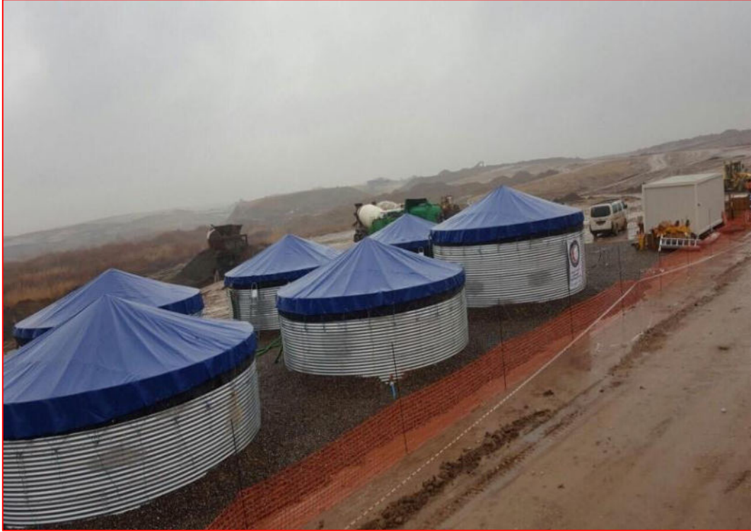
نصب خزانات للمياه الصالحة للشرب في مخيم الخازر لسد حاجة العائلات النازحة من المياه
